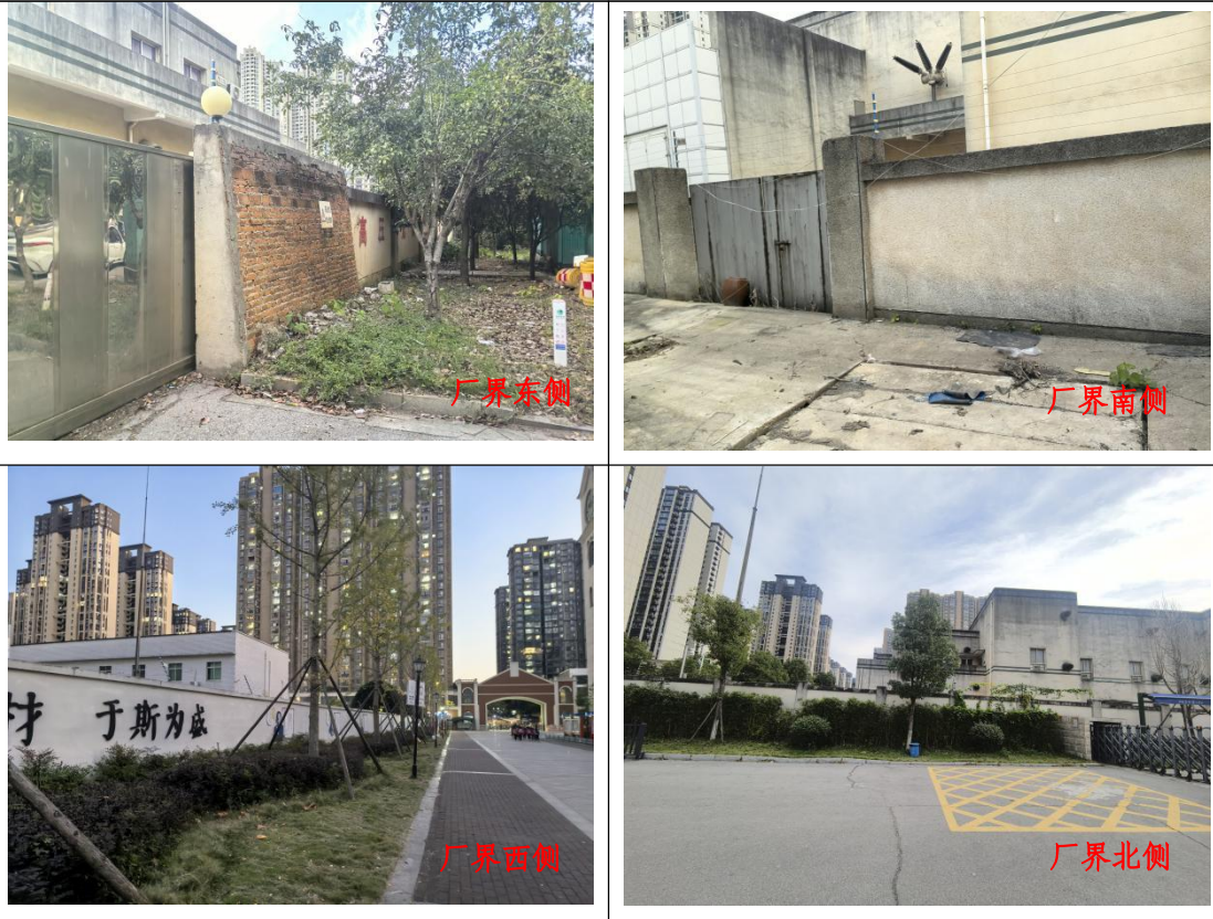
图 6 藕塘 110kV 变电站周围自然环境现状
